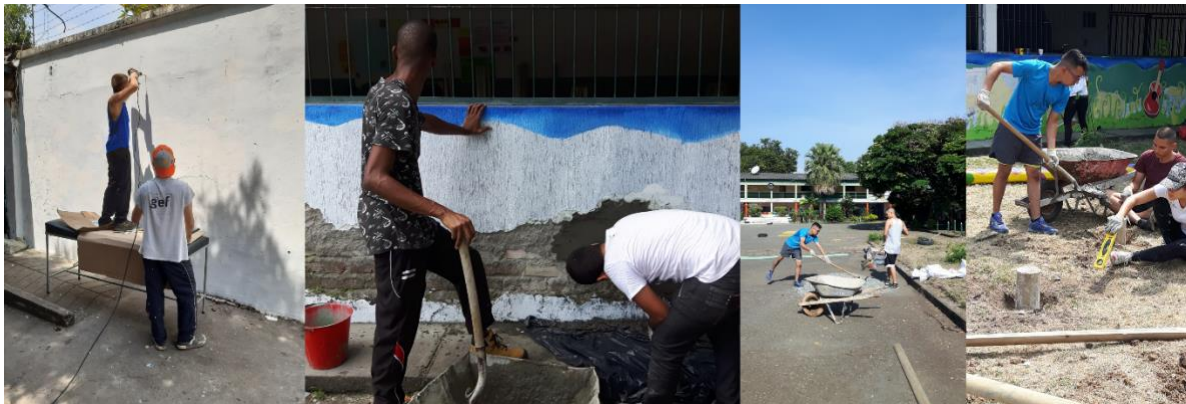
Imagen 5. Manejo de herramientas y practicas constructivas. Elaboración propia.
